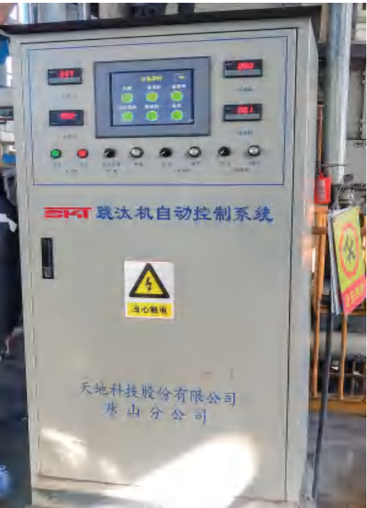
图9 选煤厂跳汰机自动控制系统
