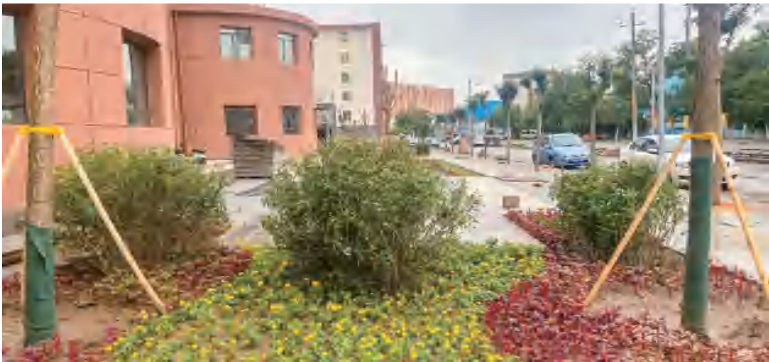
图8 本工程实施后现场照片（2）
