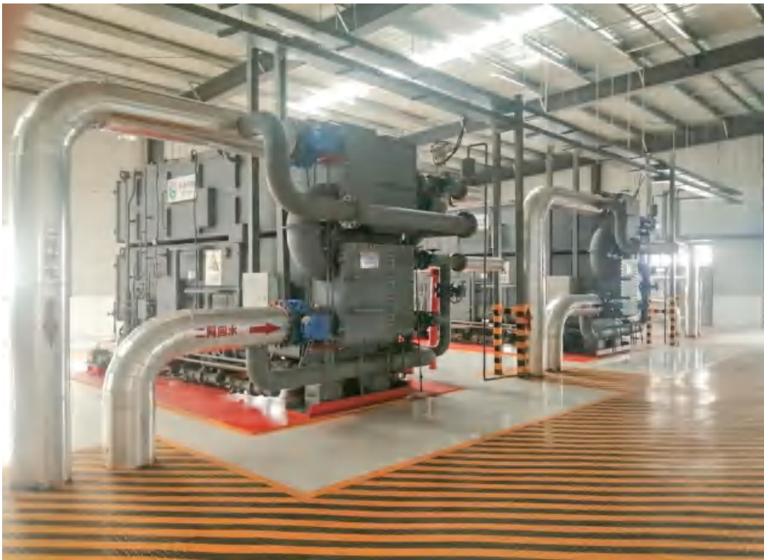
图3 吸收式热泵换热机组 1
