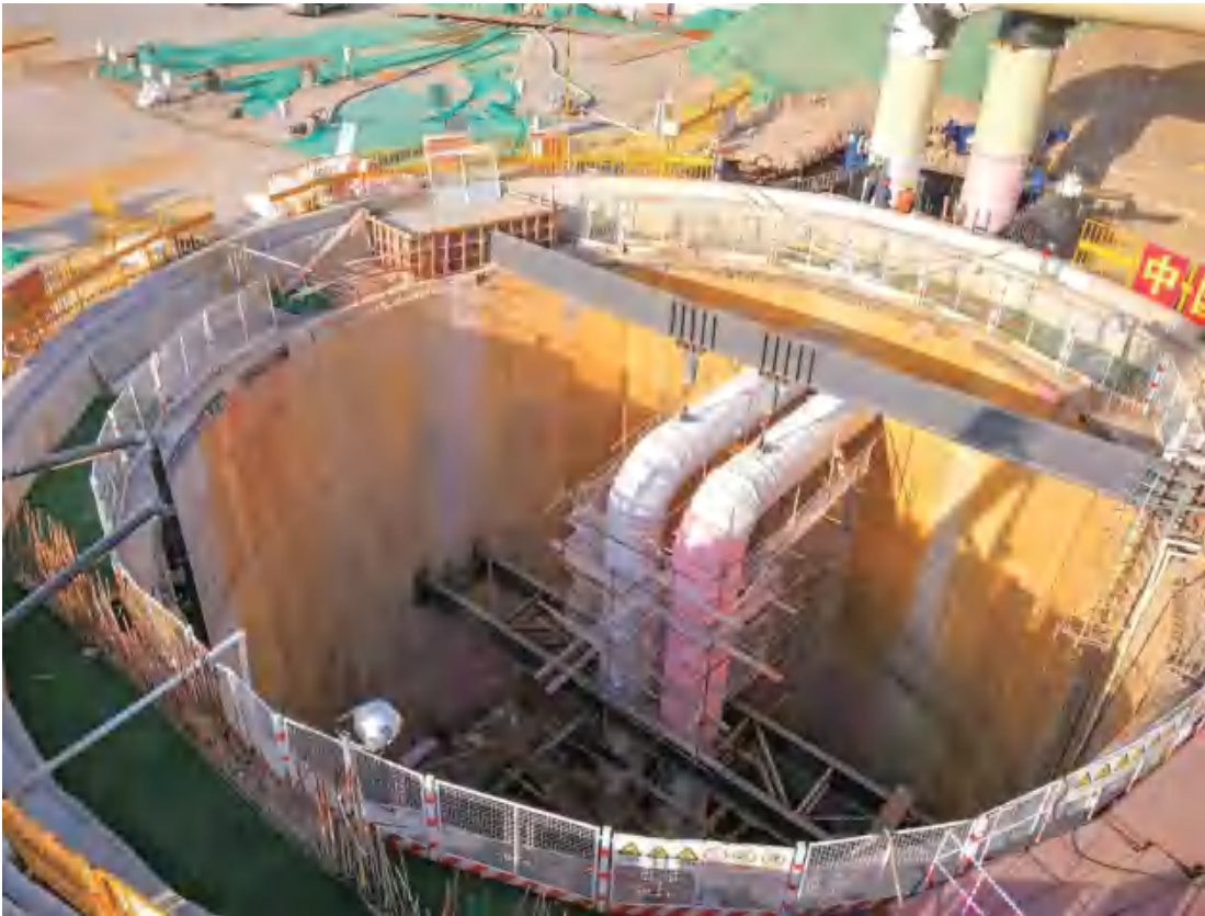
图6 黄河盾构隧道入口
