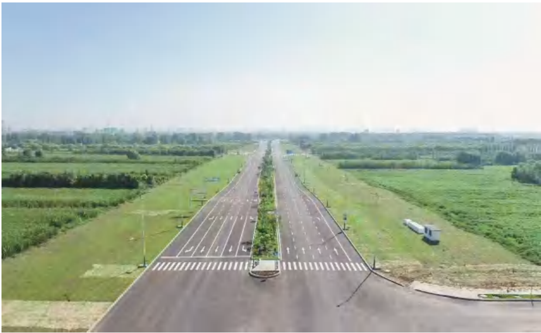
项目施工后照片
