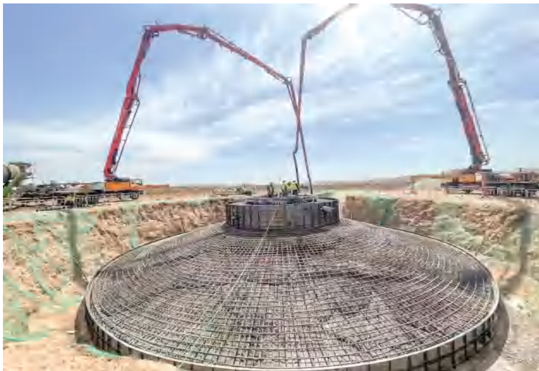
图6 实景—风机基础施工
