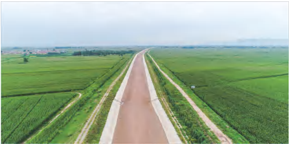
图9 镫口灌区现浇混凝土衬砌
