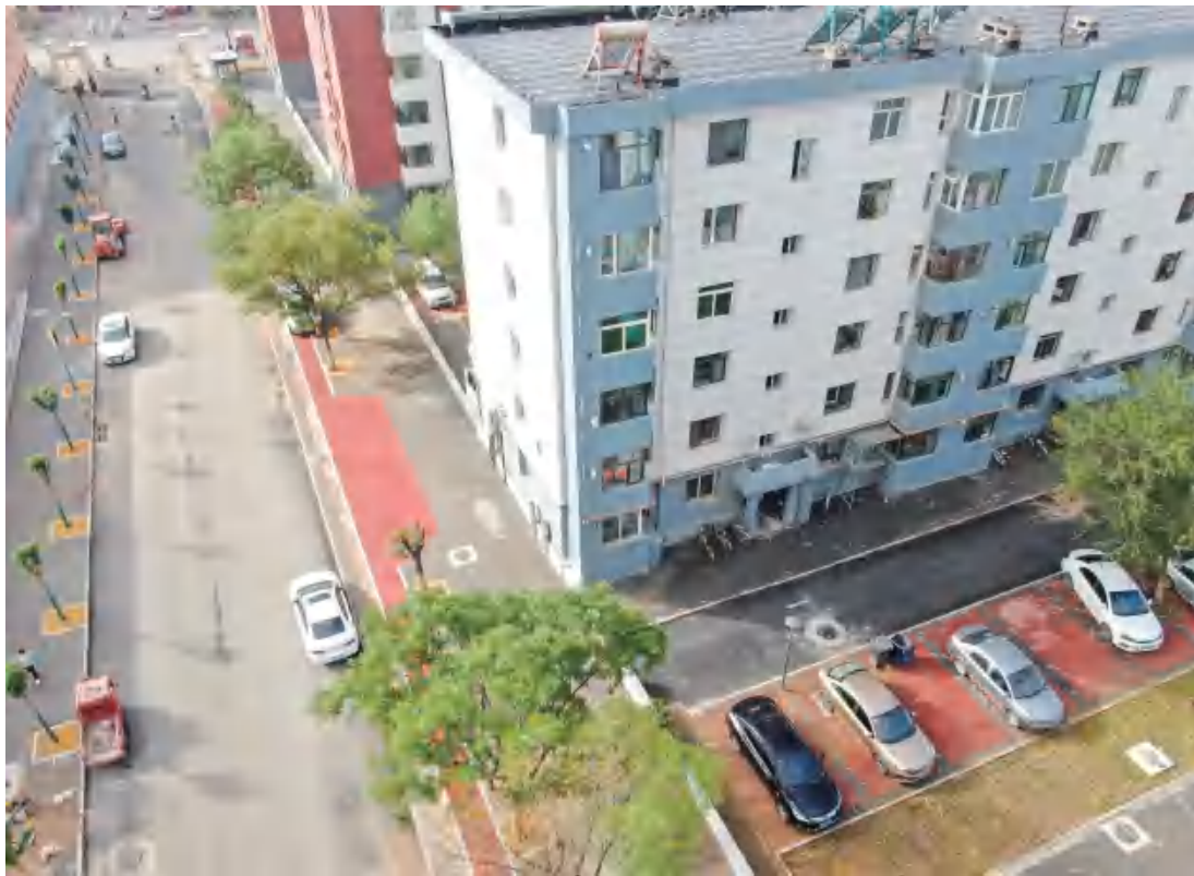
图11 本工程实施后现场照片（5）
