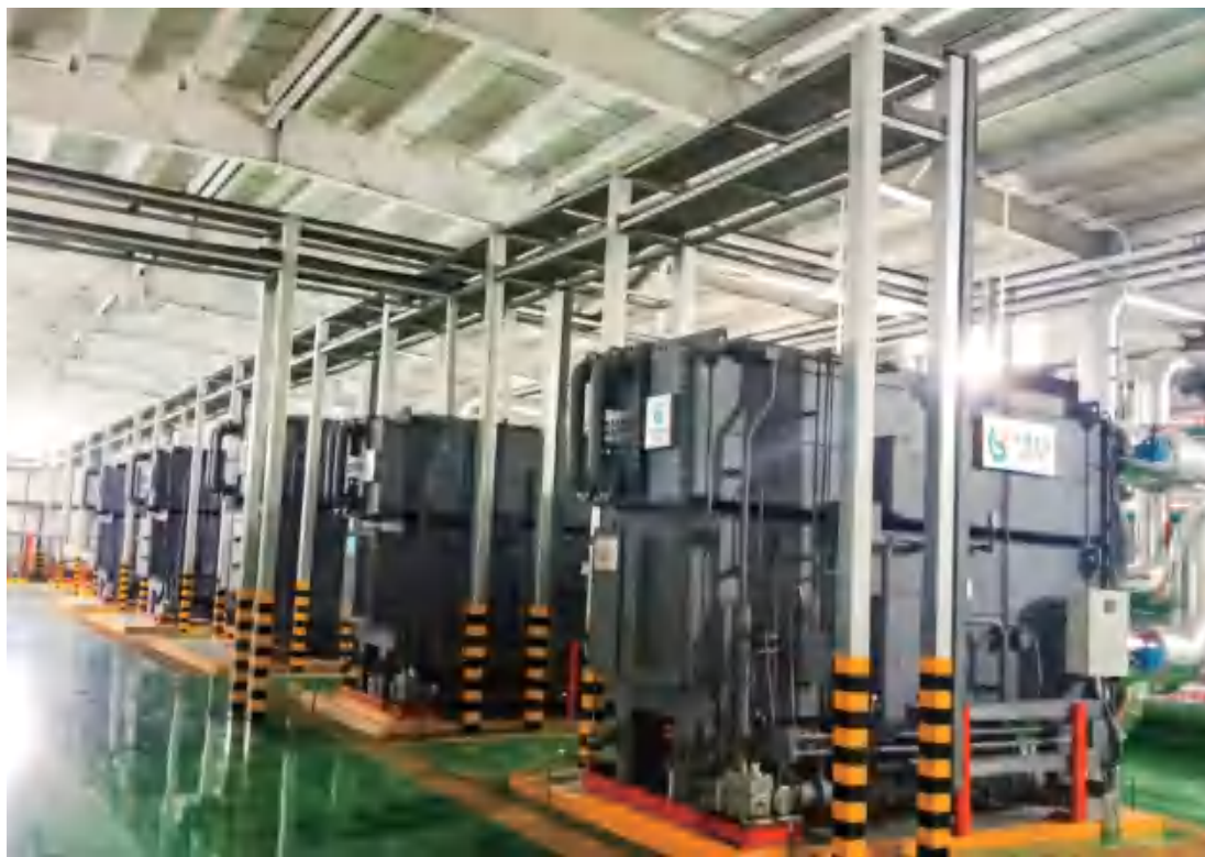
图4 吸收式热泵换热机组2
