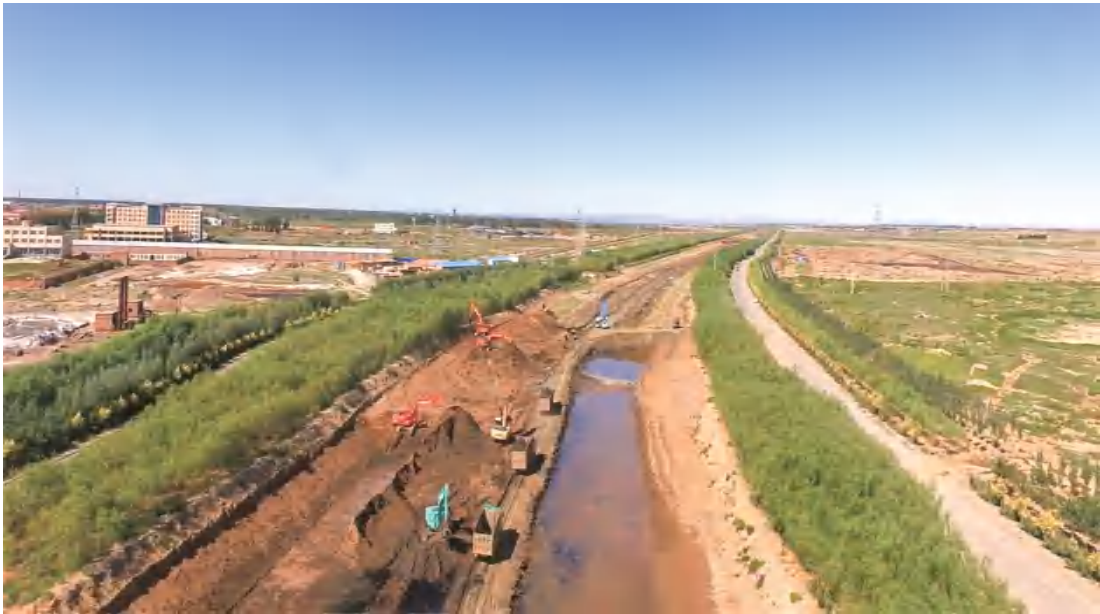
“十四五”河套灌区续建配套与现代化改造施工现场
