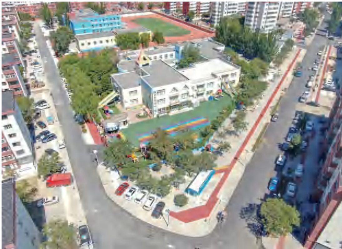
图19 本工程实施后现场照片（13）
