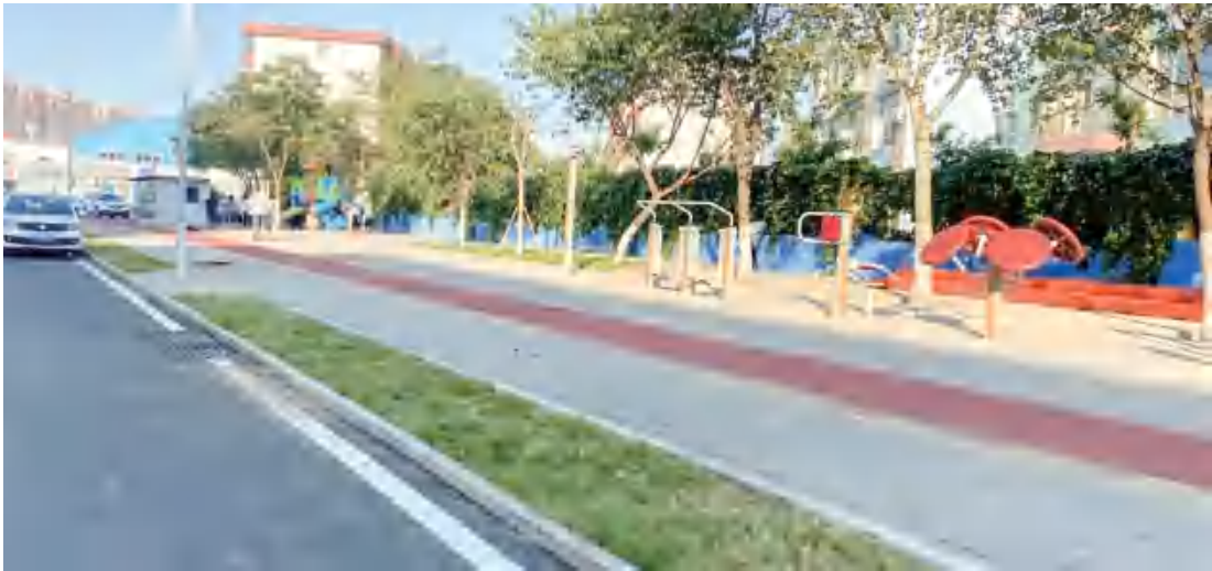
图7 本工程实施后现场照片（1）
