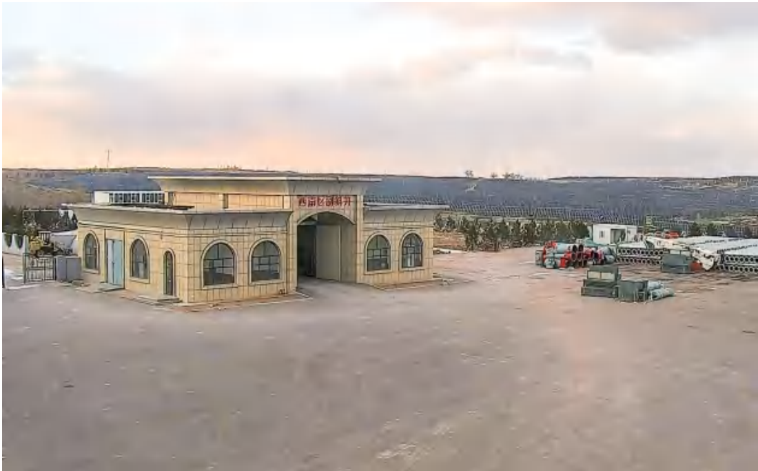
图3 西南区副斜井井口
