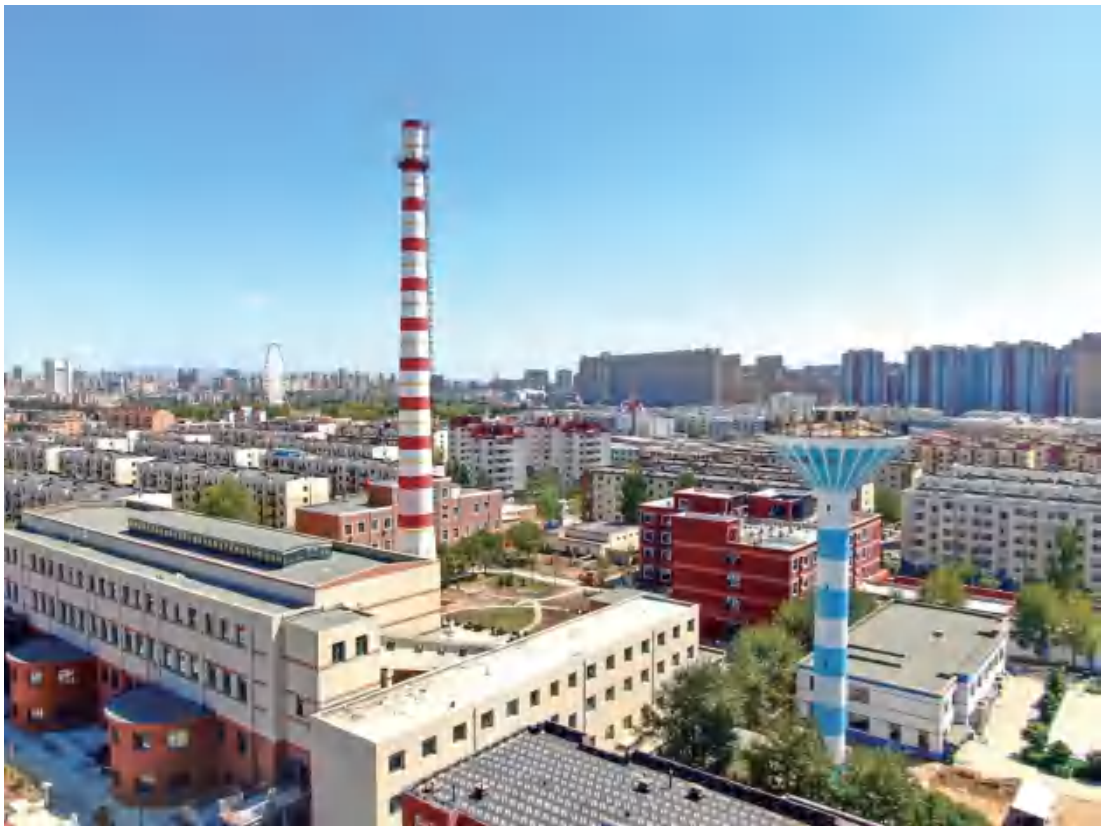
图18 本工程实施后现场照片（12）
