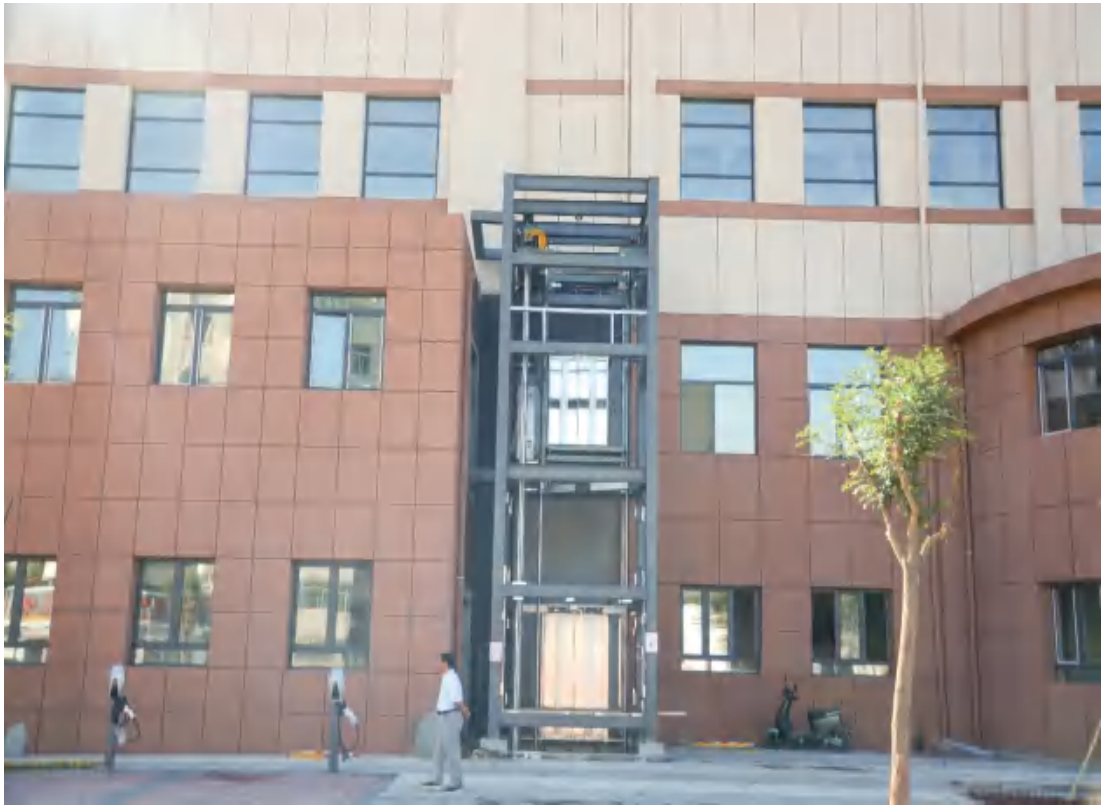
图17 本工程实施后现场照片（11）
