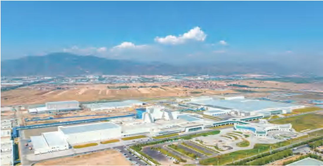
呼和浩特伊利220kV变电站投产运行
