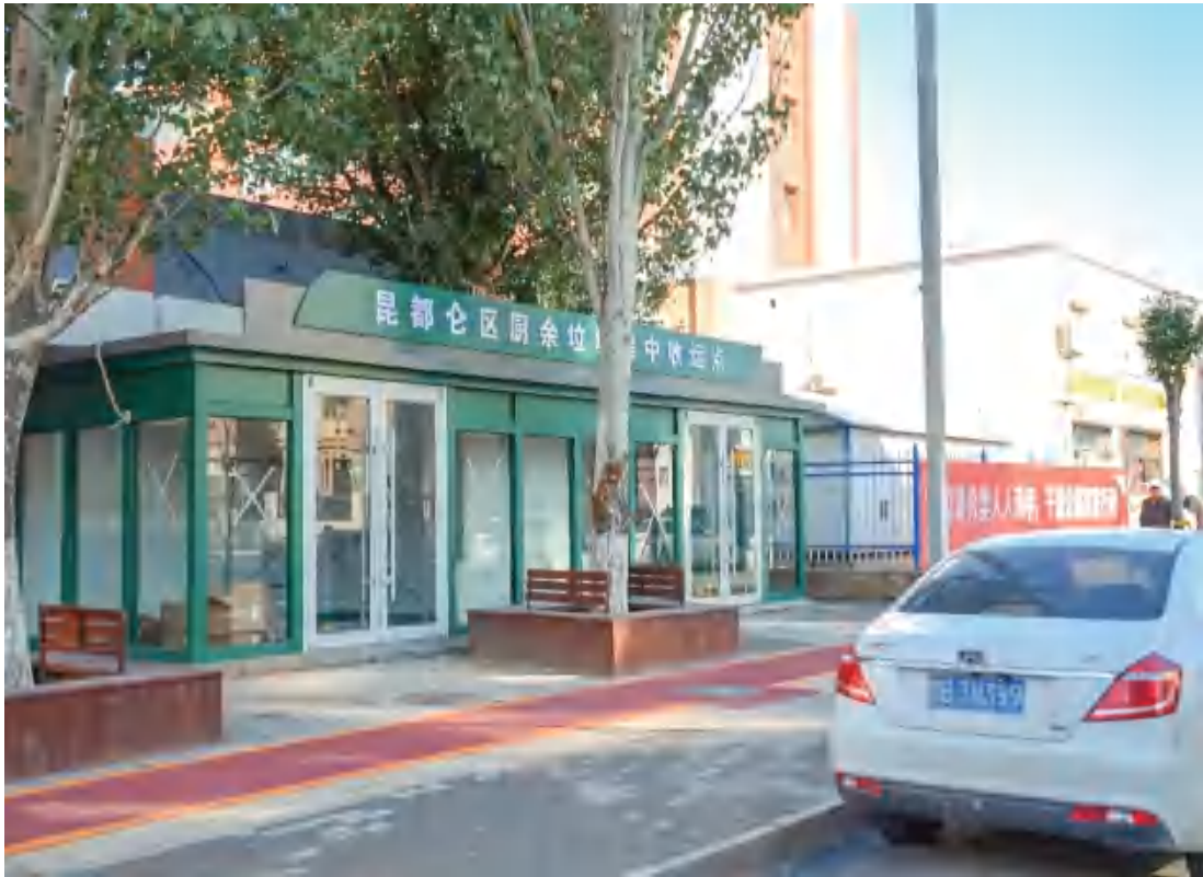
图13 本工程实施后现场照片（7）
