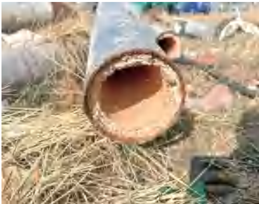
图5 改造前供水管道
