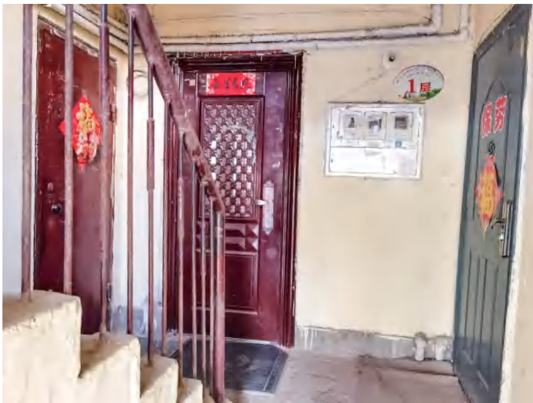
图12 本工程实施后现场照片（6）
