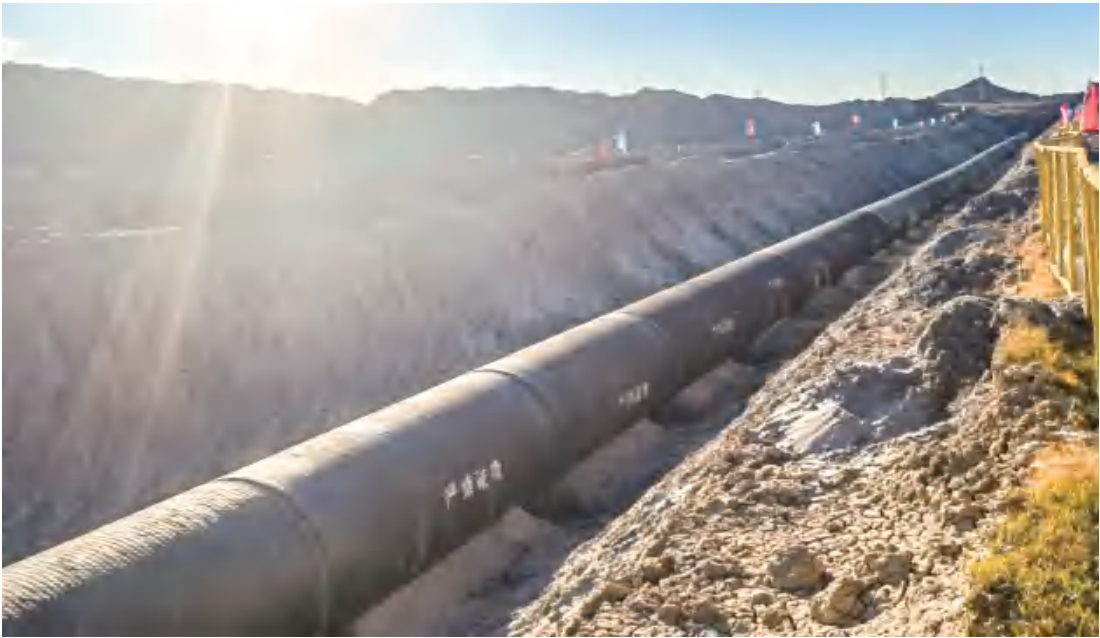
引绰济辽二期工程施工现场
