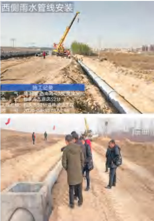
图14 排水工程现场施工照片
