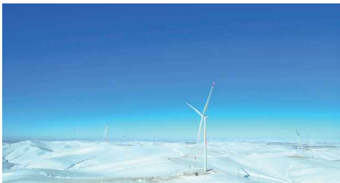
图9 实景—风电场调试
