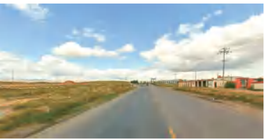
图5 现状道路照片
