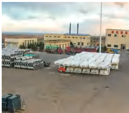
图5 副斜井厂区材料场地
