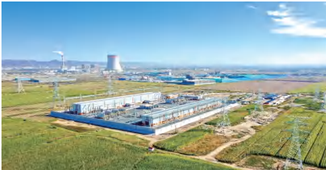
正在建设的土默特 500kV 变电站
