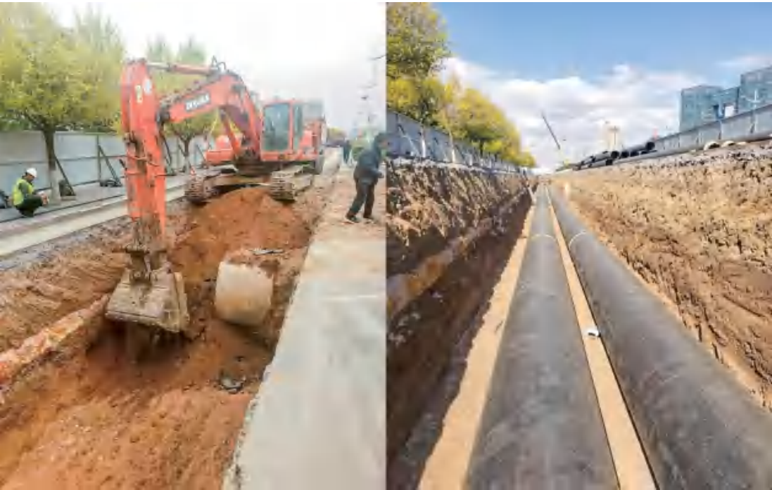
图2 供热管网施工现场图
