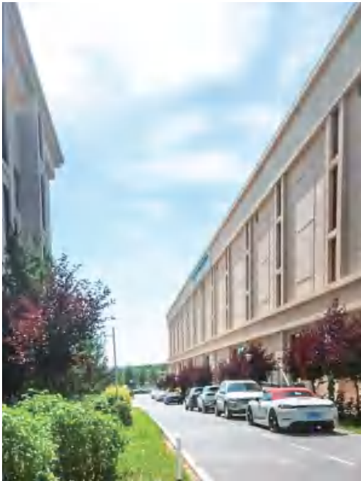
图6 现状照片（南立面）
