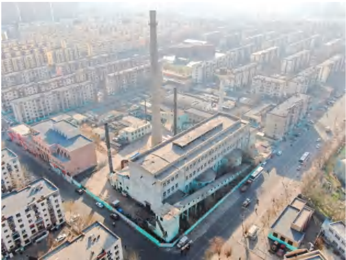
图2 小区未改造现场照片
