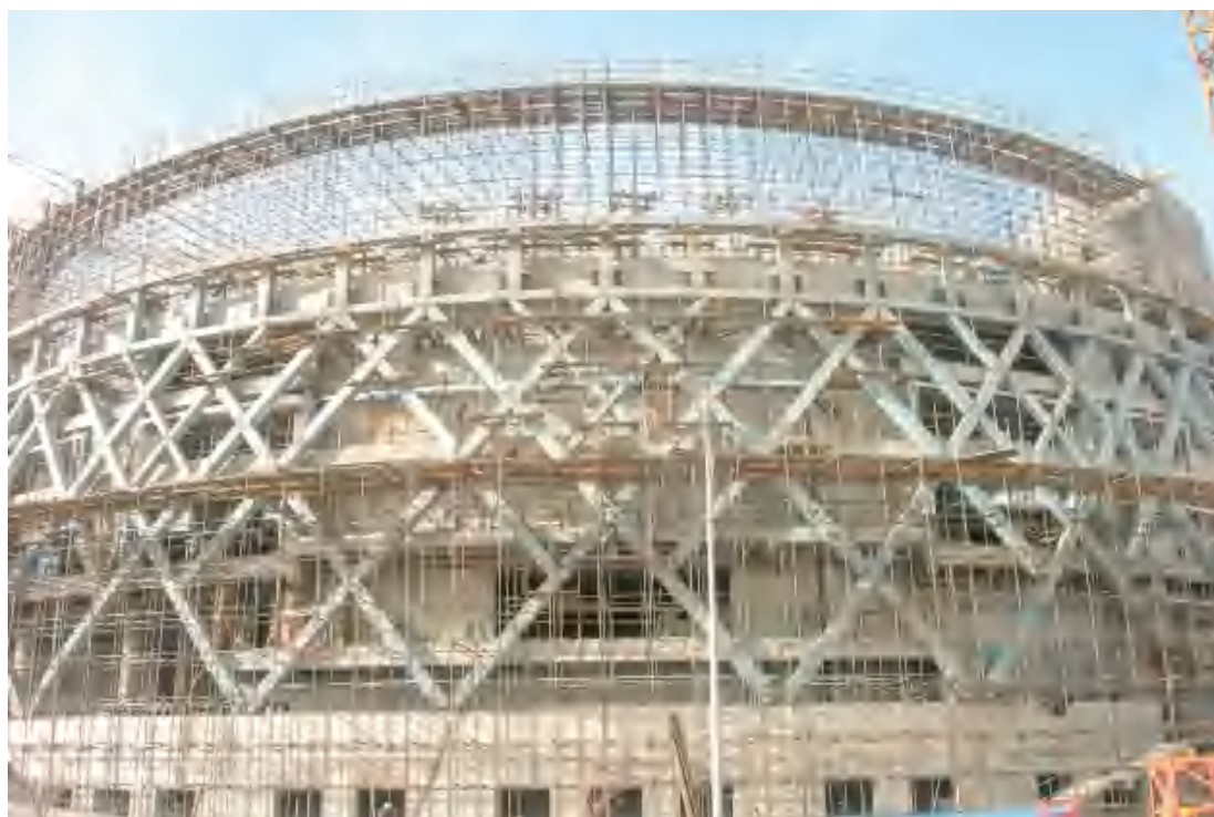
施工现场主题结构实景
