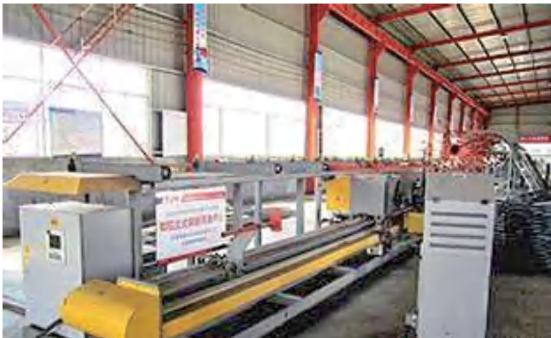
钢筋加工车间示例
