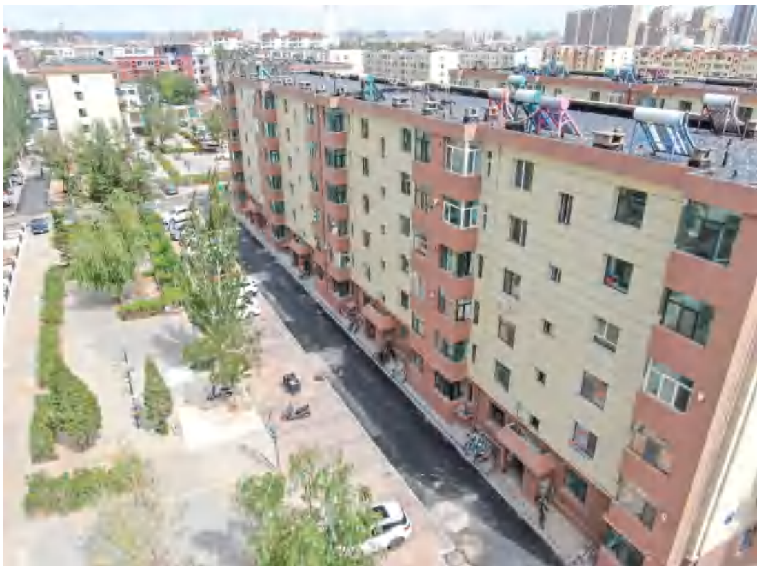
图10 本工程实施后现场照片（4）
