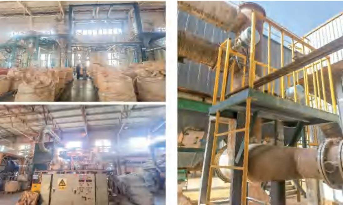
图2 老厂区粉碎设备、环保设施及物料转运现状图
