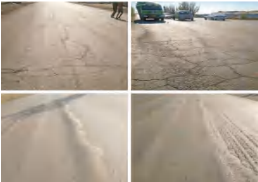
图2 沥青路面典型病害照片
