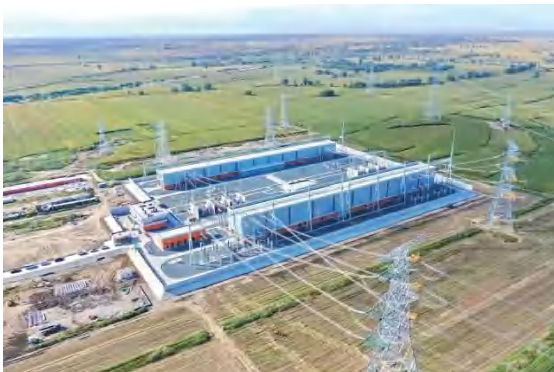
土默特 500kV 变电站投产运行
