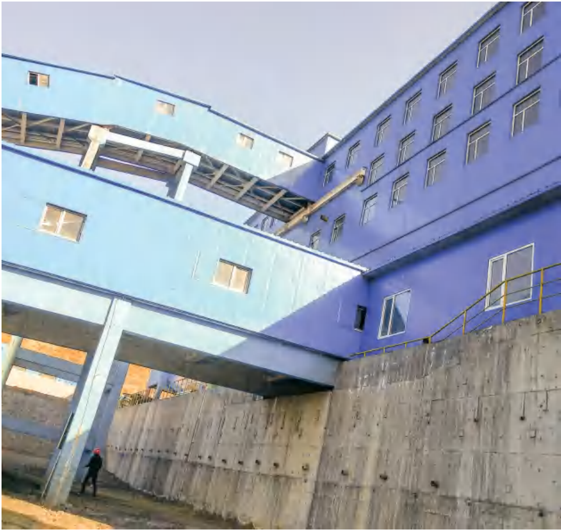
图4 单项建构筑物跨已有两级边坡建设现场图
