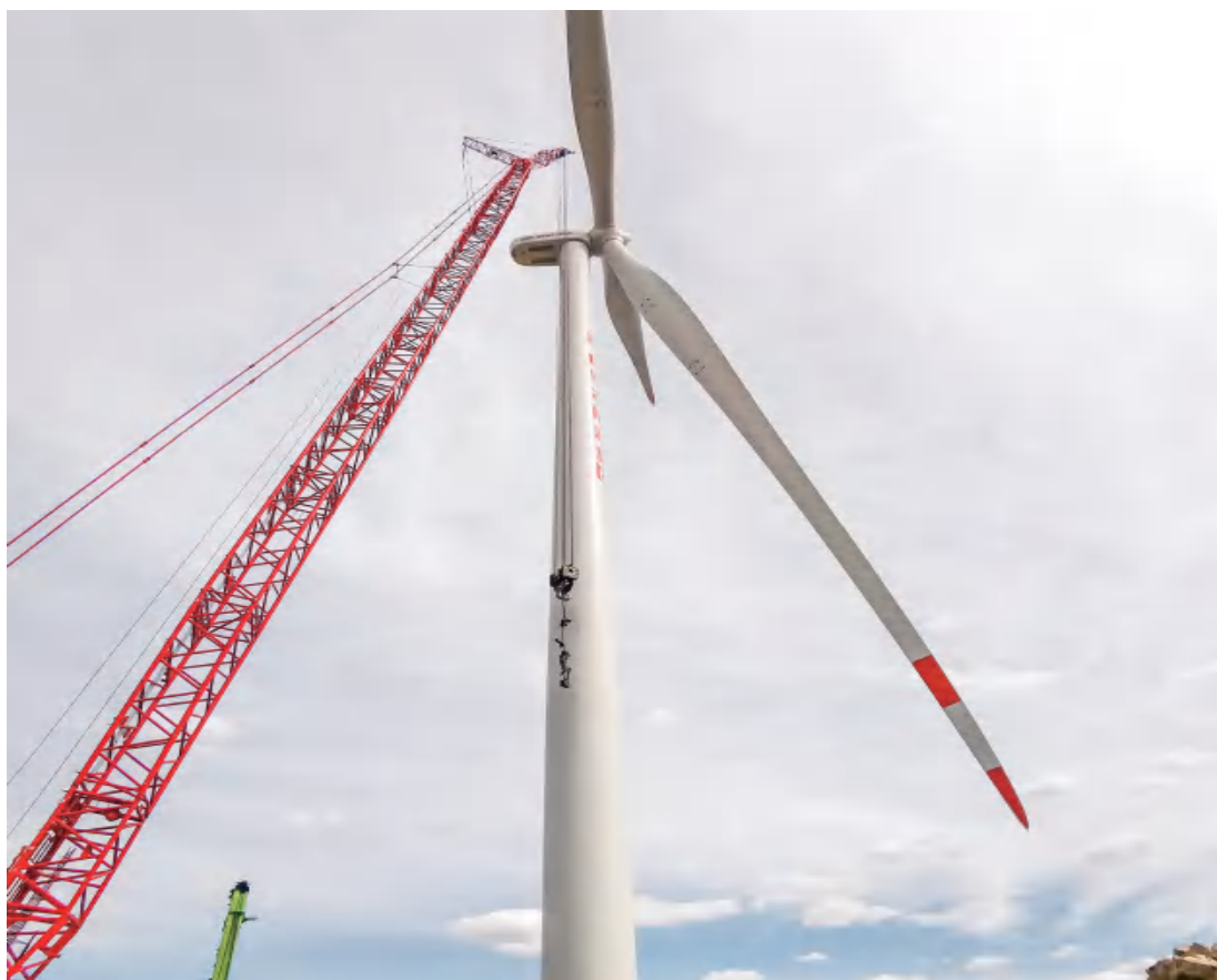
图7 实景—风机吊装
