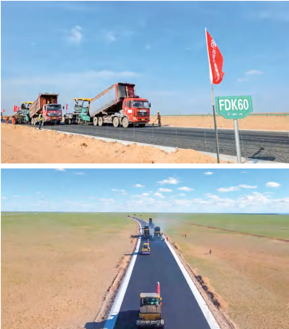
图2 项目建设中照片
