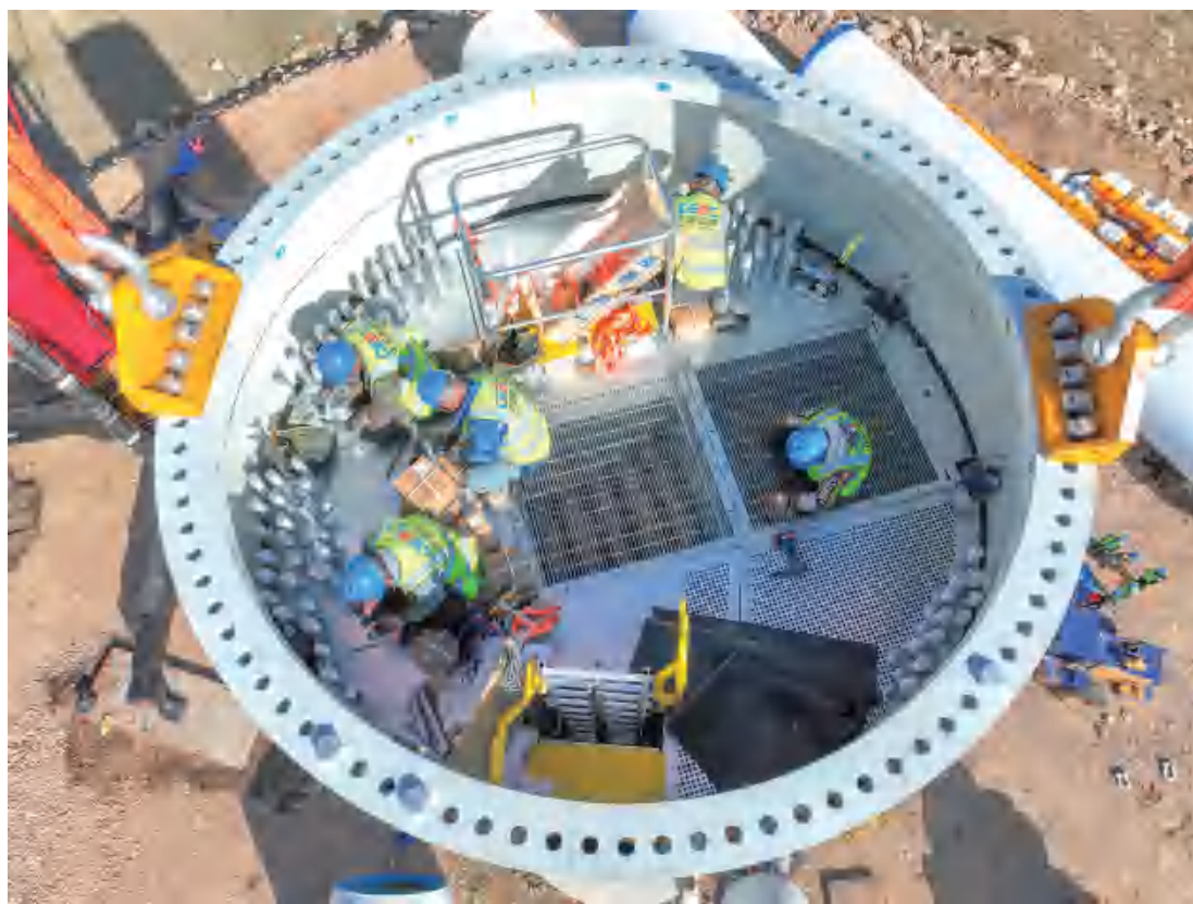
图8 实景—风机塔筒顶部安装
