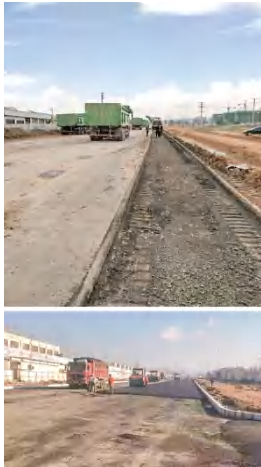
图12 道路工程现场施工照片
