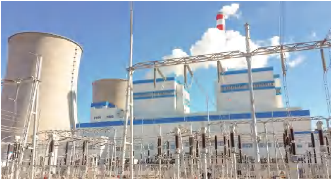
图4 京宁热电厂现场图
