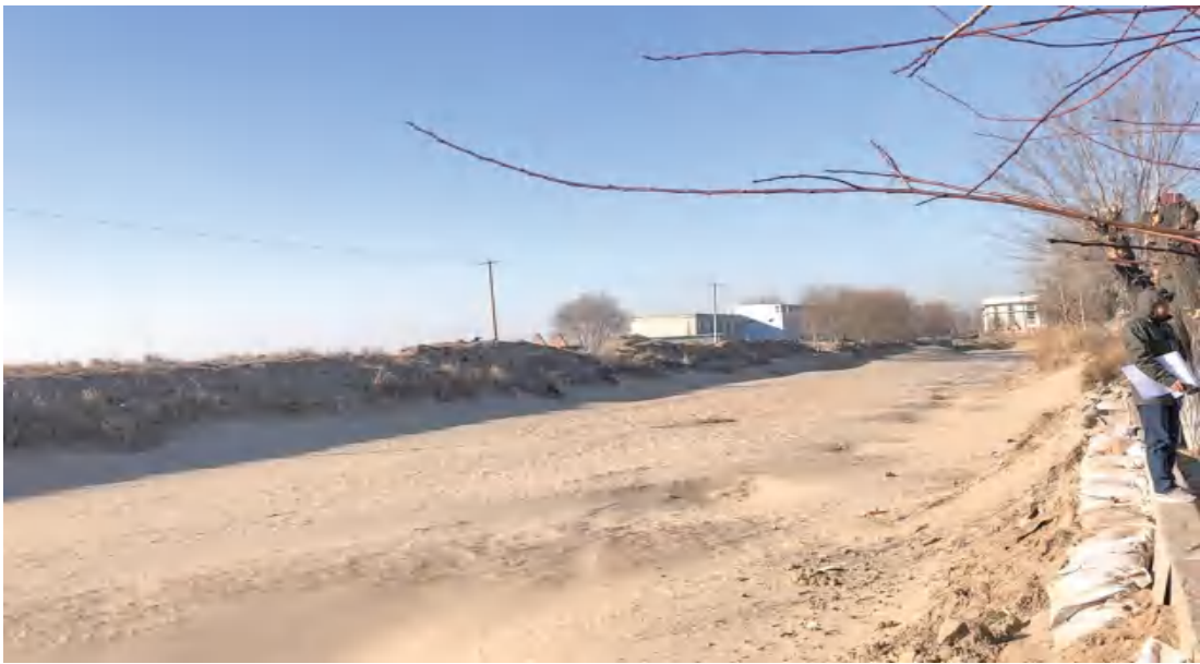
图2 总干渠0+000-6+300段渠道淤积现状
