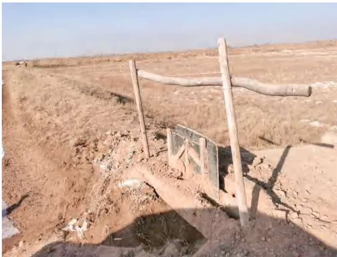
图5 支渠进水闸现状
