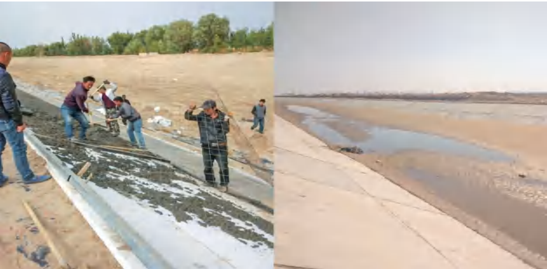
图11 现浇钢丝网混凝土与保温一体化衬砌施工与建成效果
