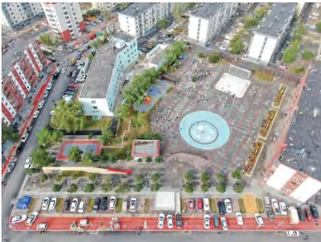
图20 本工程实施后现场照片（14）
