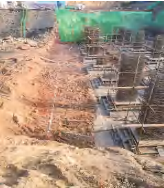
图10 选煤厂建设期全景
