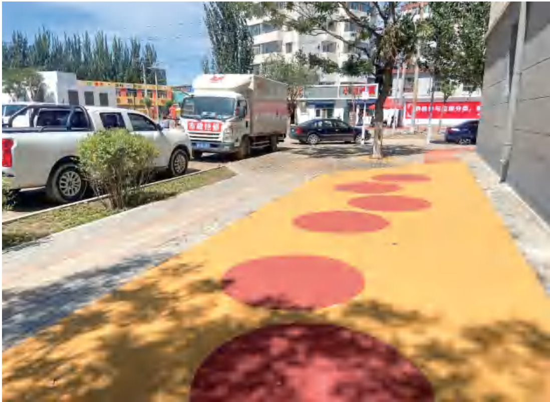
图9 本工程实施后现场照片（3）
