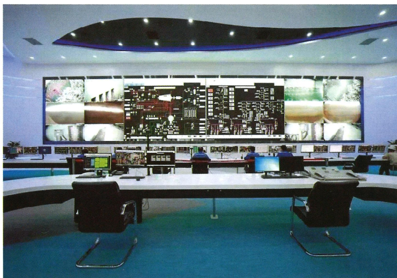
图3-2 绿色: 老港再生能源利用中心二期
