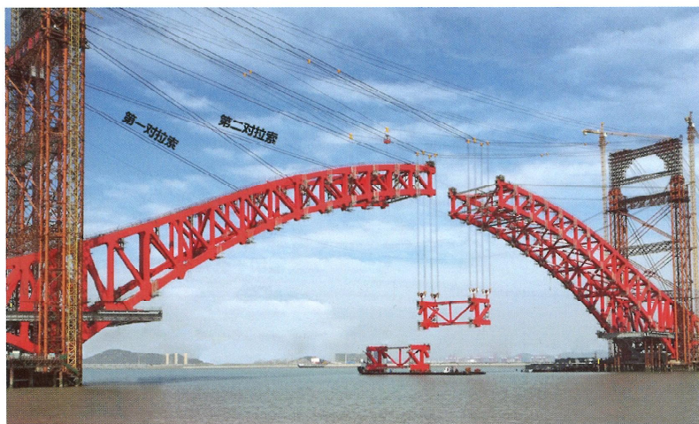
图9 主拱少扣索吊装示意图
