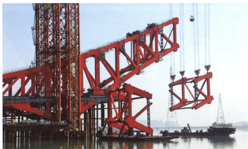
图7 整体节段吊装
